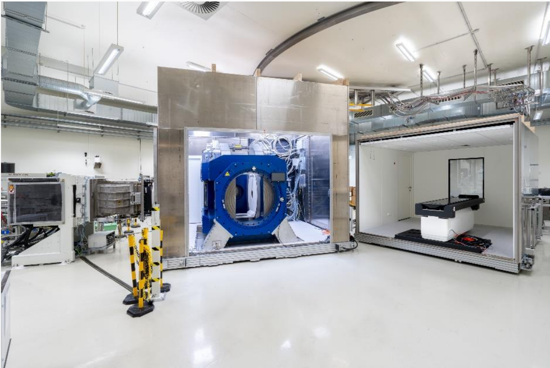
Oddělené RF kabiny pro magnet a patient couch
